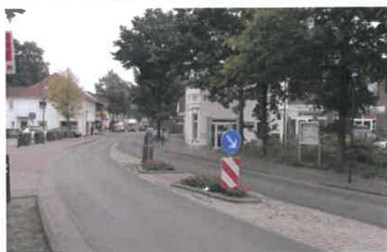
Querungshilfe am nördlichen Ortseingang
