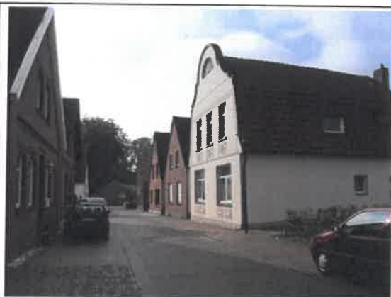
Wohngebäude in der Mühleneschstraße
