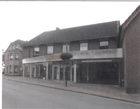
leerstehendes großflächiges Ladenlokal
