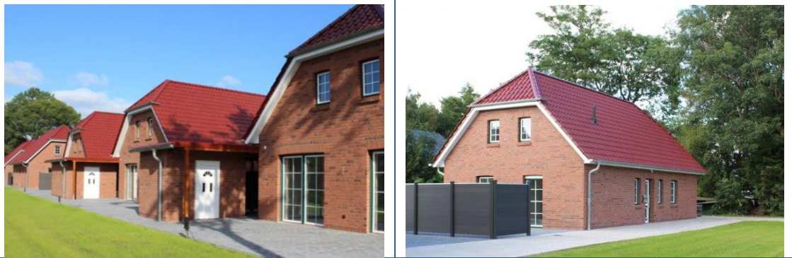
Abb. 11 Beispielhafte, den Bauvorschriften entsprechende Bebauung im Plangebiet
